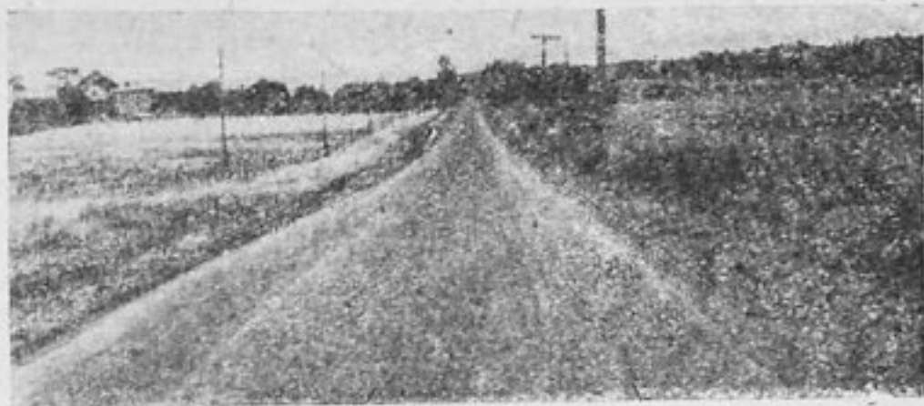
Вид улучшенной гравийной дороги
