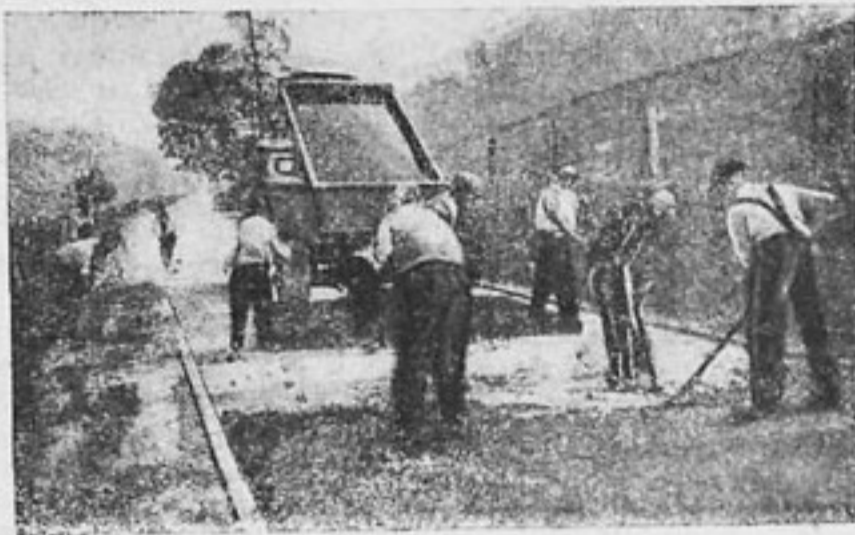
Рассыпают асфальтовую смесь по дороге
